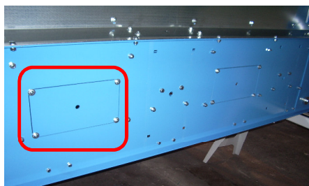
wielu otworów konserwujących w ciężkiej, masywnej płycie stalowej na obrzeżach konstrukcji
